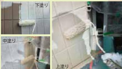
基本的に3回に分けて塗装していきます。「下塗り」はその上から塗る塗料がはがれないように接着するため。「中塗り」は塗膜に厚みを持たせ、「上塗り」で仕上げとなります。
